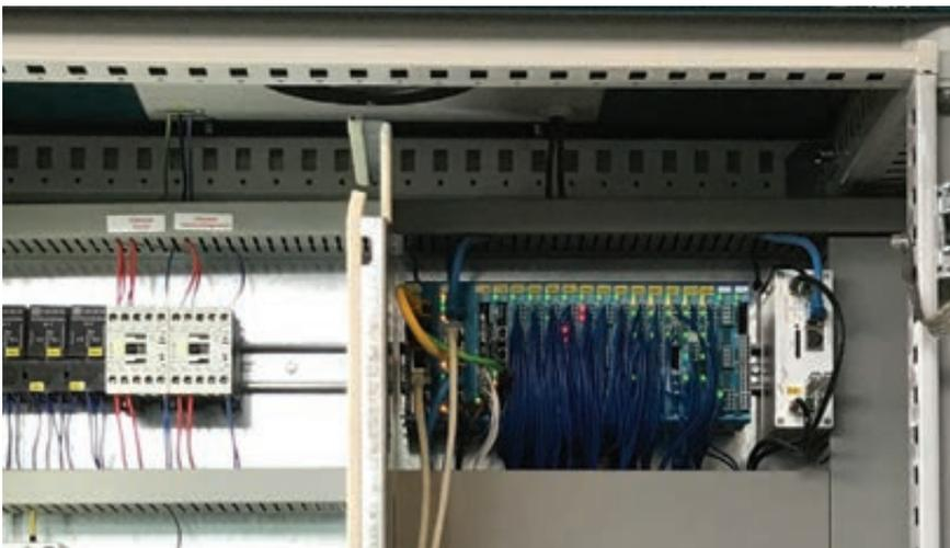
*Die »S-Dias«-Steuerungstechnik von Sigmatek punktet mit hoher Performance, kompakter Bauform sowie mit zahlreichen kleinen, durchdachten Details, wie beispielsweise die LED-Statusanzeige der I/Os.*
